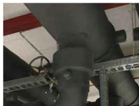
d) 冷温水・ブライン配管
