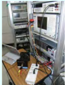
電力計測ユニット校正システム
