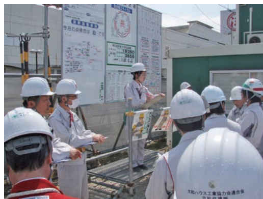
▲女性施工職の職場の様子
