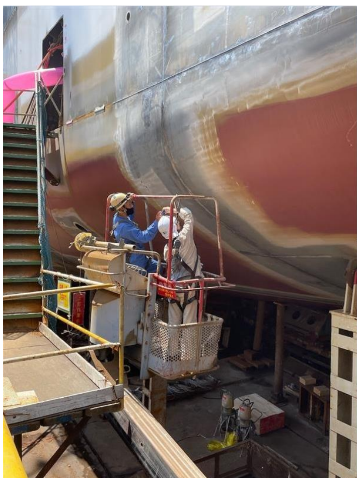
▲造船所にて、当社技術系女性社員による船体外板の塗装検査の様子
