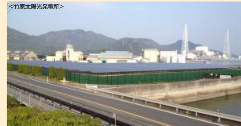
<竹原太陽光発電所>
