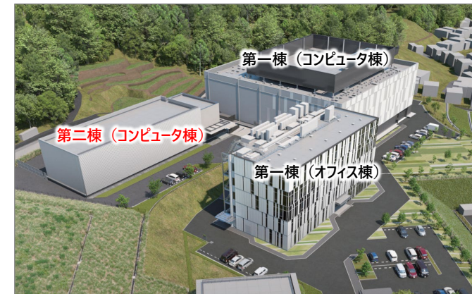
大阪第二データセンター(第二棟)イメージ
