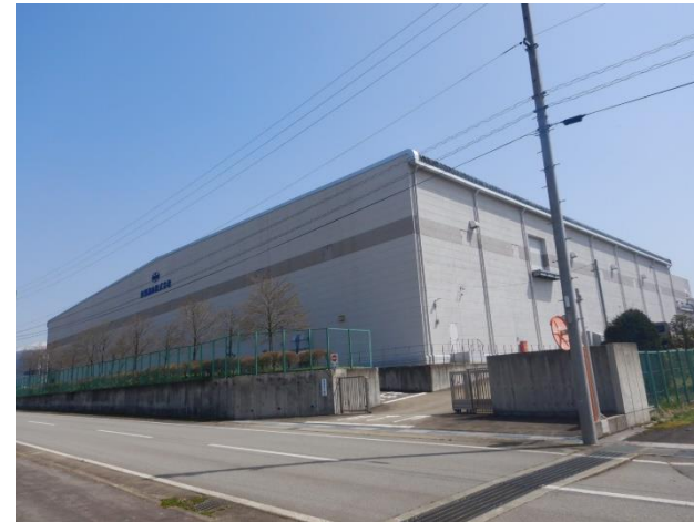
<太陽光併設蓄電池を導入する工場外観>
