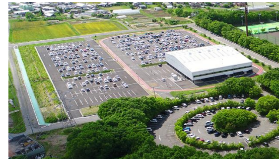
本社工場従業員駐車場
