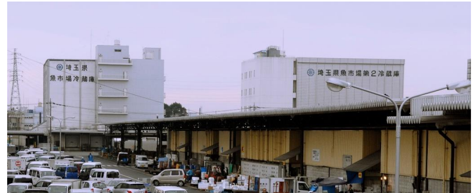
左側の建物が第1冷蔵庫
