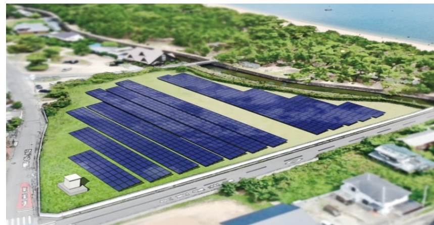
太陽光発電設備の設置
