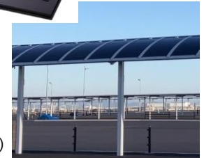
施工例 (大阪・関西万博)
