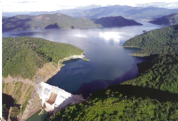
セカマン第一水力発電所 (290MW)
