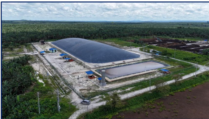
<類似案件におけるプラント建設の様子（イメージ）>
