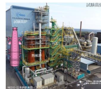
COURSE50試験高炉
