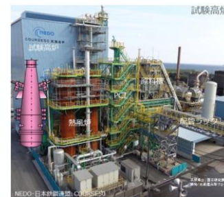
COURSE50試験高炉
