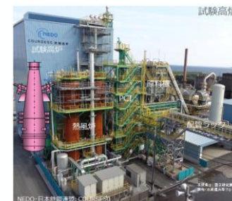
COURSE50試験高炉
