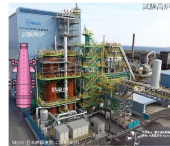
COURSE50試験高炉
