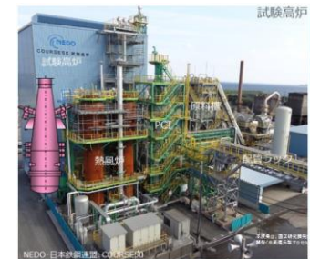
COURSE50試験高炉
