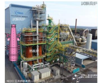
COURSE50試験高炉
