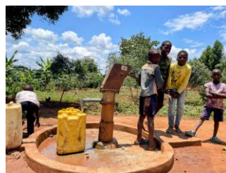
▲ Hand pump-equipped borehole
