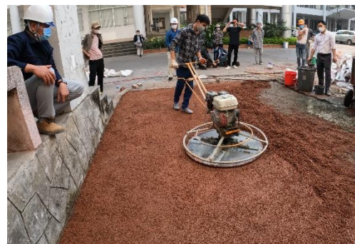
▲試験施工の様子
