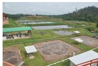
▲マレーシア パームオイル工場の排水処理場
