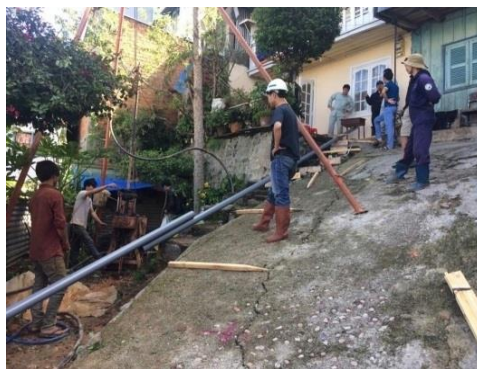
▲地すべり対策緊急調査及び地すべり観測機器設置の様子
