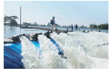
▲国際緊急援助隊による排水作業
