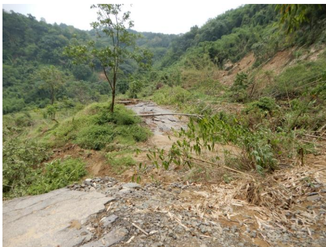
▲豪雨により斜面崩壊した山岳道路の様子
