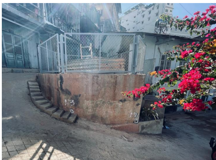
▲ダラット市内の地すべり対策工施工完了状況
