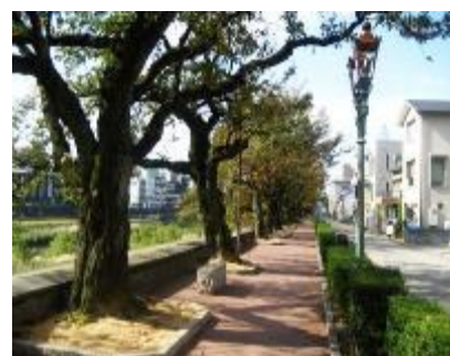
▲廃瓦・レンガで舗装した道路
