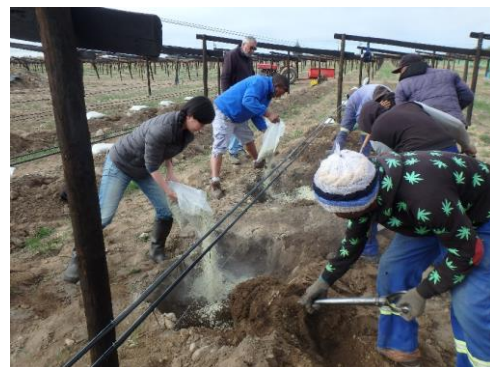
▲ポーラスαを土壌に混ぜ込む様子
