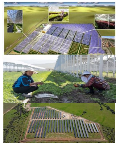
▲図3：チリ第2号案件2022年6月に建設完了
