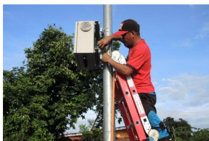
▲警報ユニットを設置する様子（イロイロ市）
