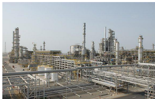
▲オマーンの石油精製プラント
