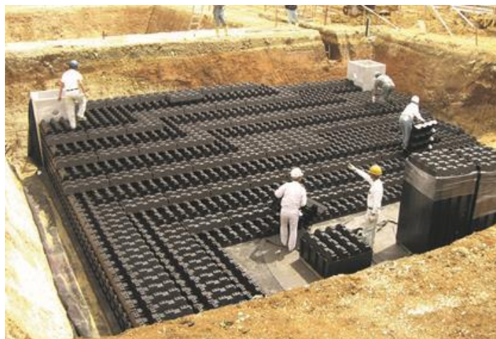
▲クロスウェーブ設置の様子
