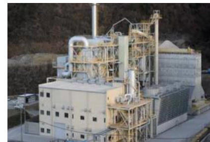
栃木工場バイオマス発電設備 (住友大阪セメント株式会社)
