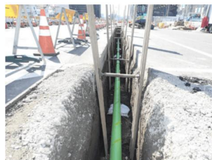
＜水素パイプライン（施工状況）＞
