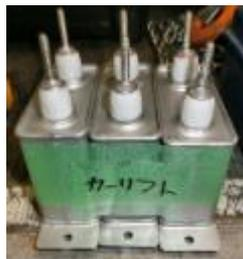
昇降機の定期点検時にメンテナンス業者等に依頼してコンデンサーの銘板から製造年を確認。
