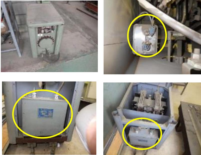
電気溶接機には低圧コンデンサーが側面又は内部に設置されている。側面に設置されていない場合は、蓋を開け内部に設置されているか確認する。
