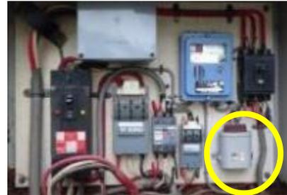
低圧分電盤内の低圧コンデンサー
