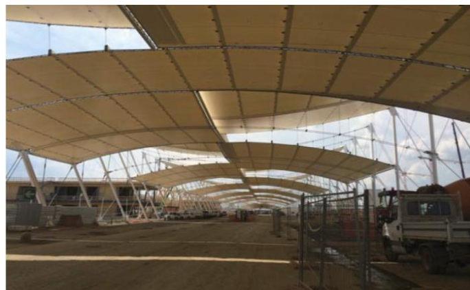
大屋根取付後のデクマヌス（中央大通り）
