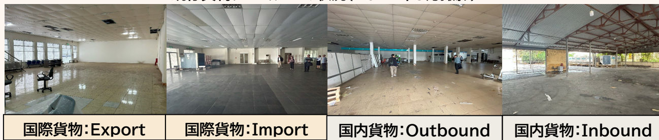
既存貨物ターミナルの状況(2024年5月撮影)
