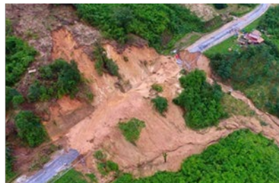
写真 2 道路の土砂被害
