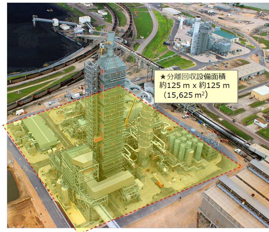
図 3-86 Petra Nova CCUS プロジェクトの CO 2 分離回収設備範囲
