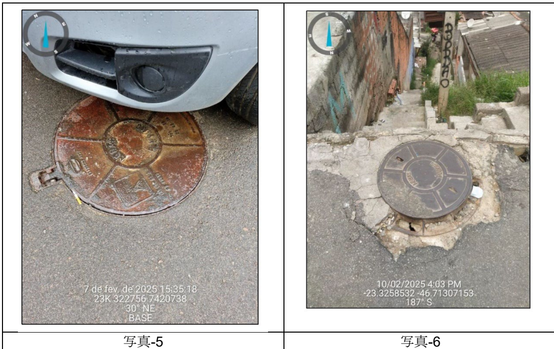
図 2.10 「フランコダローシャ市のマクロおよびマイクロ排水ネットワークの登録と地理の参照 2025」の写真の抜粋 4)
