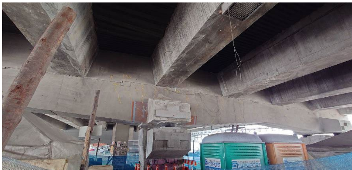
橋脚のひび割れ注入と外ケーブル補強工事の状況（Av.Calle 6 × Av. Cra.30交差付近）
