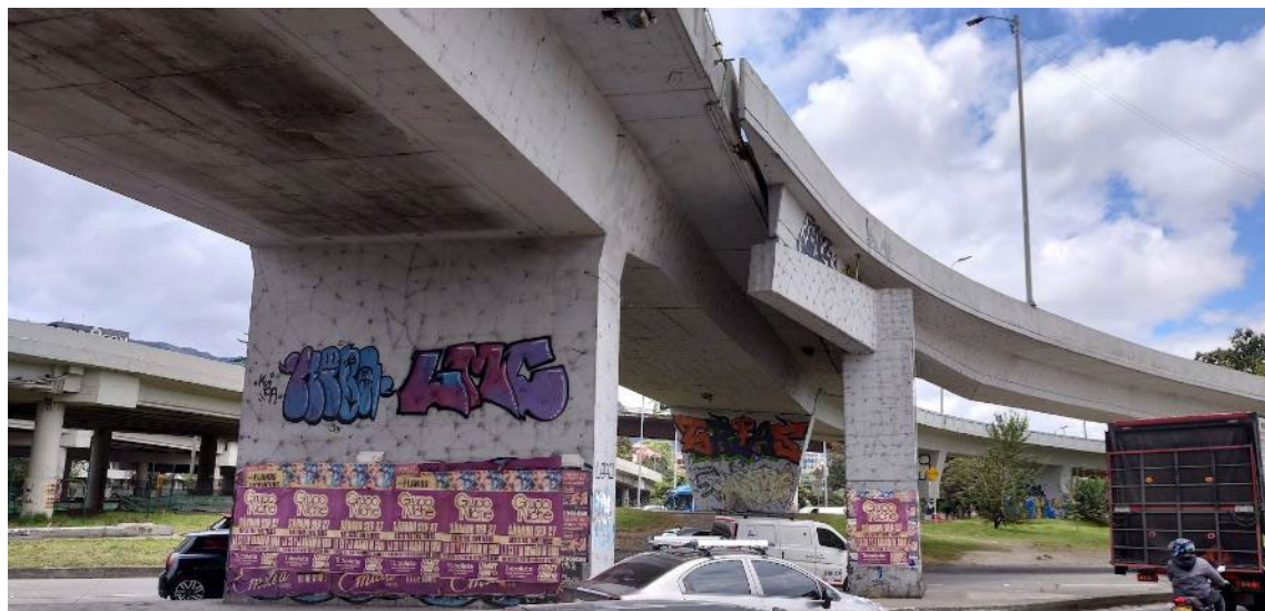
密な状態で2方向に発現したひび割れの補修後（Av.Calle 92 × Autopista Norte交差付近）
