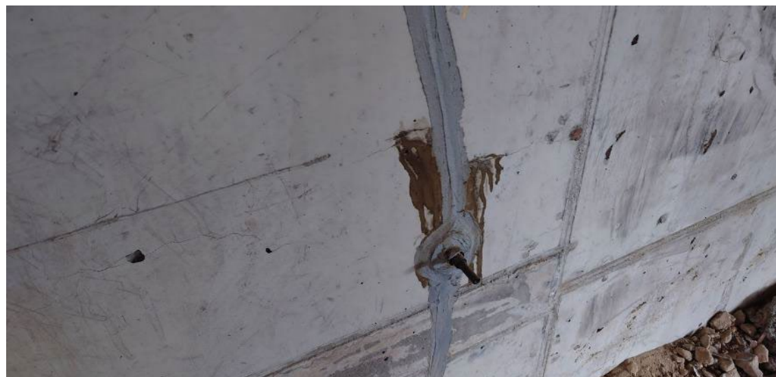
ひび割れ注入後の状況（Av.Calle 26 Sur × Av.Cra. 68交差付近）
