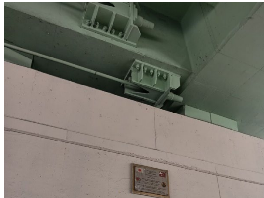
梁を拡大延長して補強
