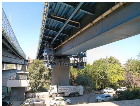
基礎が軟弱なため支柱は鋼板巻き立ての上、ボルトで固定した
