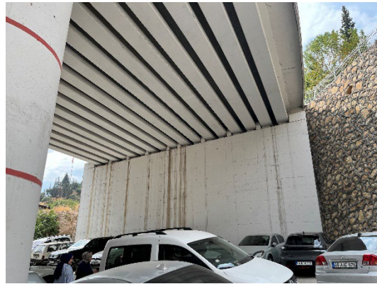
変位した制限構造の補強
