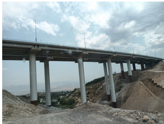
補強状況全景
