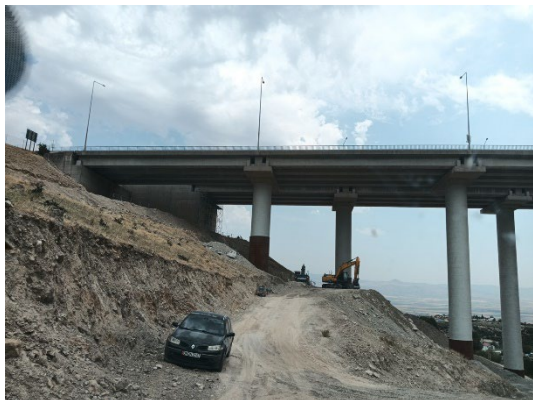
補強状況全景
