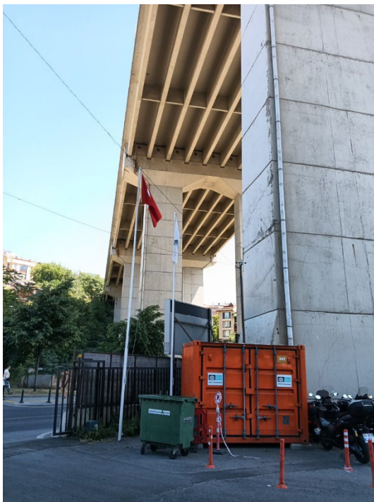
橋脚のRC巻き立てと橋桁端部の連結
