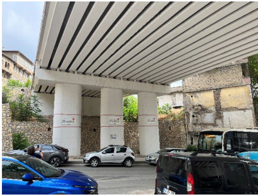
変位した制限構造の補強
