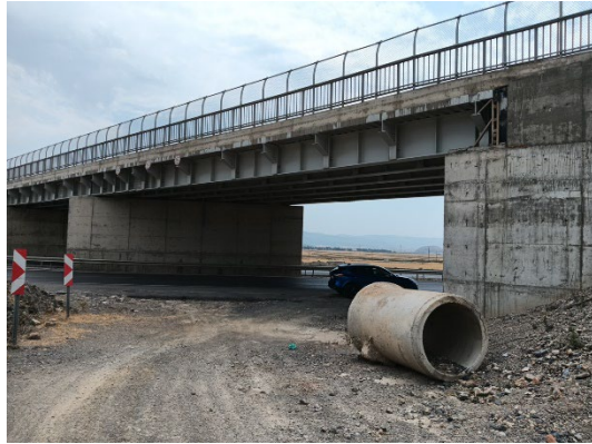
鋼桁に掛け替えられ、中央部に下部構造が追加された様子
