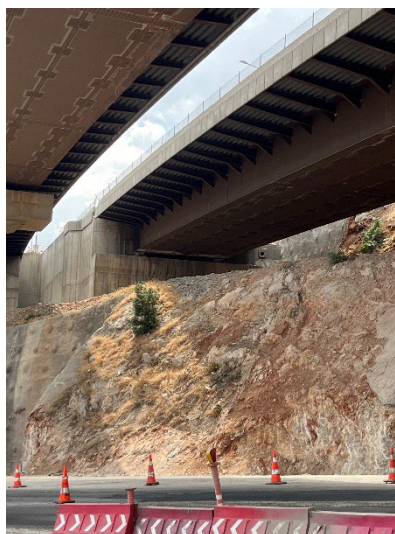
橋台部はそのままで補強しているように見える
