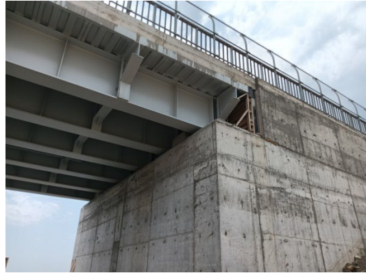
橋台は延長され、補強されているように見える
