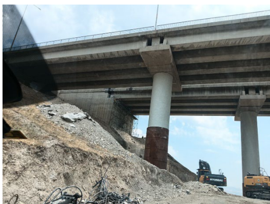
橋脚部の鋼板巻き立て
