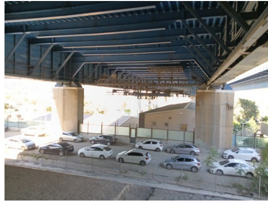
既存橋脚上部の支承取り換え
