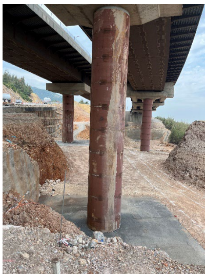
橋脚陪鋼管巻き立てと基礎を 1m ずつ拡大
