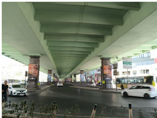
各支柱頂部に免震ゴム支承を挿入
