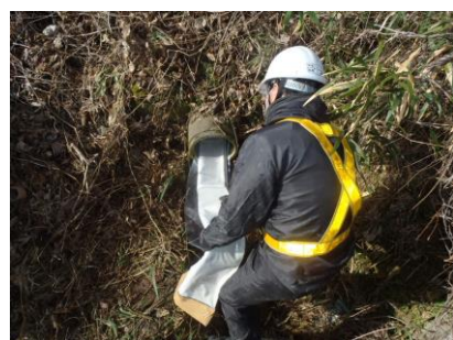
〈ライニング工事〉
