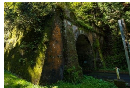
山中トンネル
