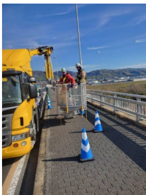
橋梁点検車での施行
