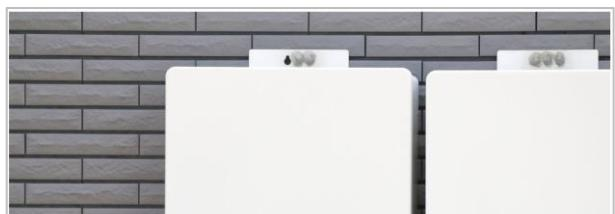
電気を貯める「蓄電池」。太陽光発電を組み合わせることで、昼間効率的に発電して電力を蓄え、夜間にその電力を使用することができ、節電にも繋がります。万が一の災害や停電が発生しても、非常用電源として役立ちます。これからは、自宅で電気を「つくる・ためる」時代。太陽光発電+蓄電池システムで電気を自給自足すれば、いざというときに安心が生まれます。
