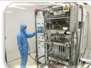
(写真: 中工場内部)
