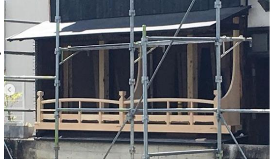
釘を1本も使わず仕上げた 欄干取付工事
