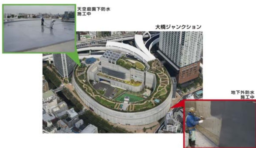
ダイフレックスの防水施工の実例
