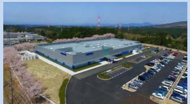
再建されたテラデザイン熊本事務所
