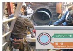
例：管路の耐震補強
