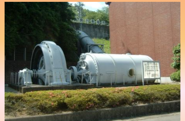
【長良川水力発電所の発電機(岐阜県美濃市)】
