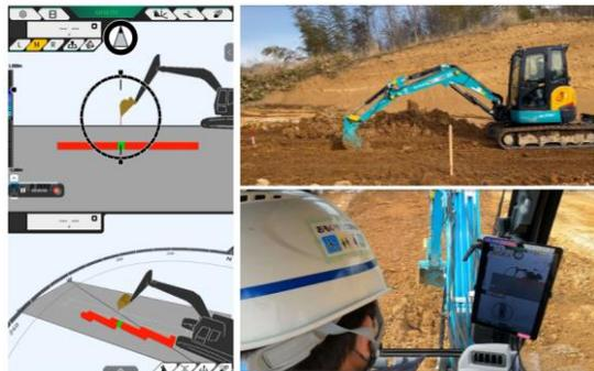
マシンガイダンスを用いて、施工目標を視覚化することで、建設機械の操作者の操作性を向上させる等
