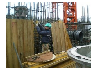
【コンクリートを流し込むための型枠を組み立てる様子】
