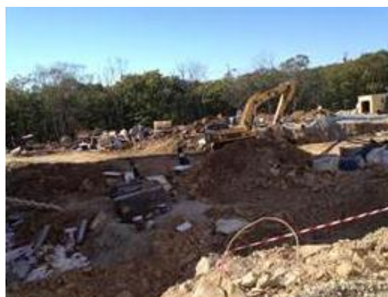
放射線治療部が入る予定の別館建設現場
