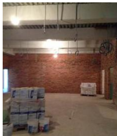
建設中本館内部
