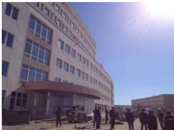
建設中本館外観
