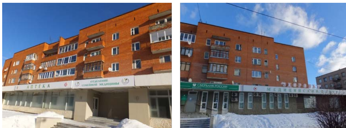
図表・29 建物の外観（左と右の建物は1つに繋がっている）
