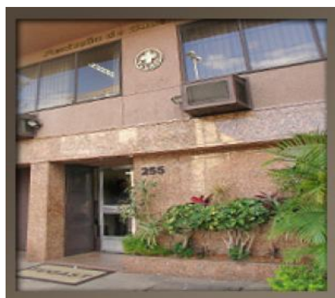
図表・8 フガスト病院外観
