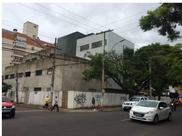
図表・39 建設中の新棟外観
