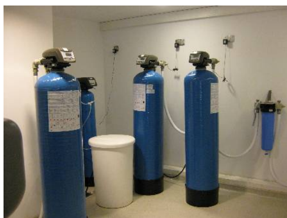
図表・11 透析用貯水タンク、透析用濾過装置
