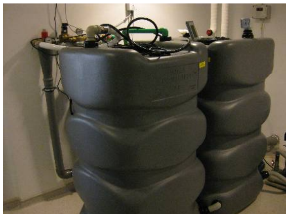
図表・11 透析用貯水タンク、透析用濾過装置
