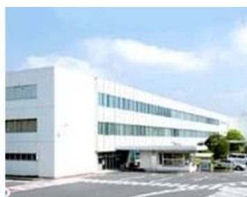
図・表 28 日機装静岡工場
