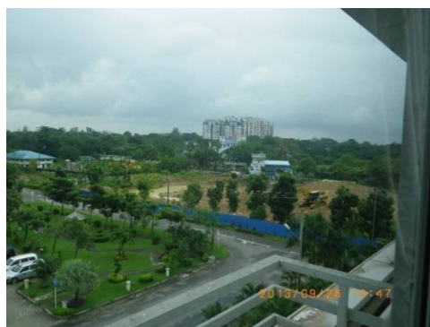
建設中の専門治療施設「がん&婦人センター」
