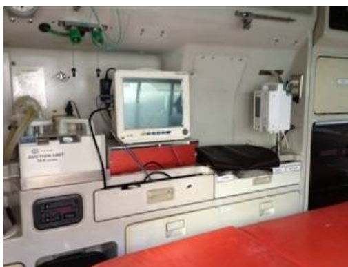
EAS 救急車内部（輸液ポンプ）
