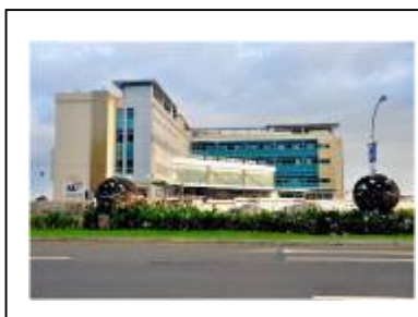
↑完成されたセントール病院(全景) (右側棟の後方に肝移植センター)
