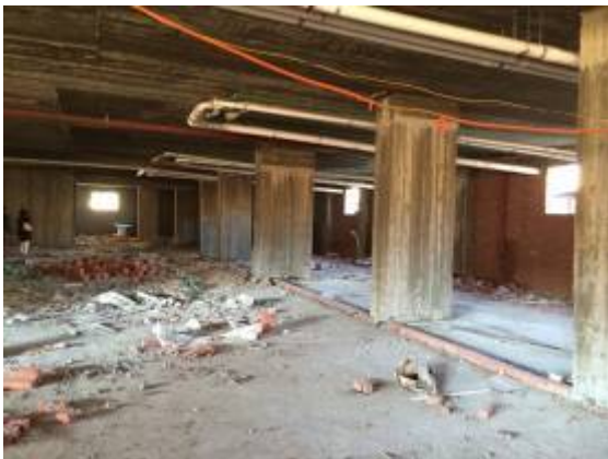
B1F 厨房予定スペース
