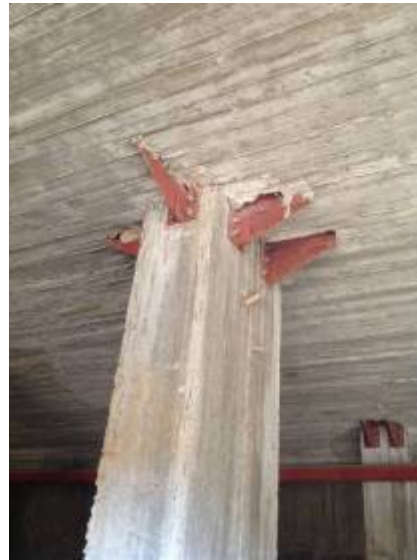
B2F 柱頭 B2Fのみ柱頭に鉄骨の補強がみられた。
