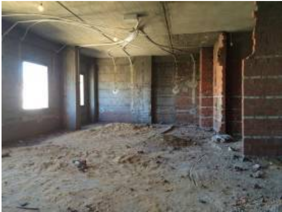
3F ICU 予定スペース
