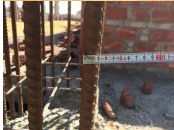
屋上 増築の為の準備としての露出鉄筋 柱主筋は異型鉄筋 D22 程度
